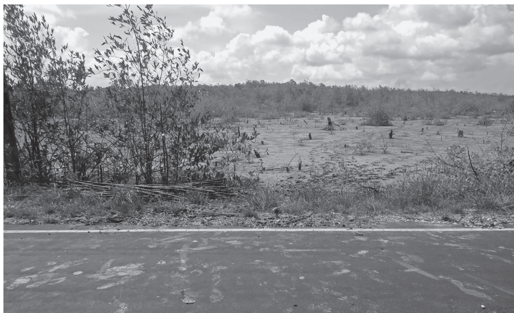
Figura 3: Área de manguezal atingida pelo aterramento, às margens da PA-458 (Foto: Márcio Couto Henrique, 2015)
