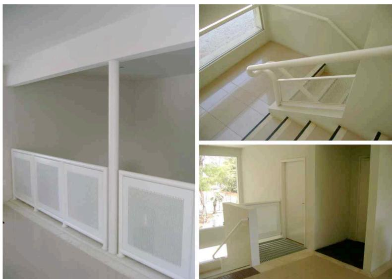
Figura 07 – Guarda-corpos instalados no Prédio 19 do CIENTEC. Fonte: elaborada pelos autores.
