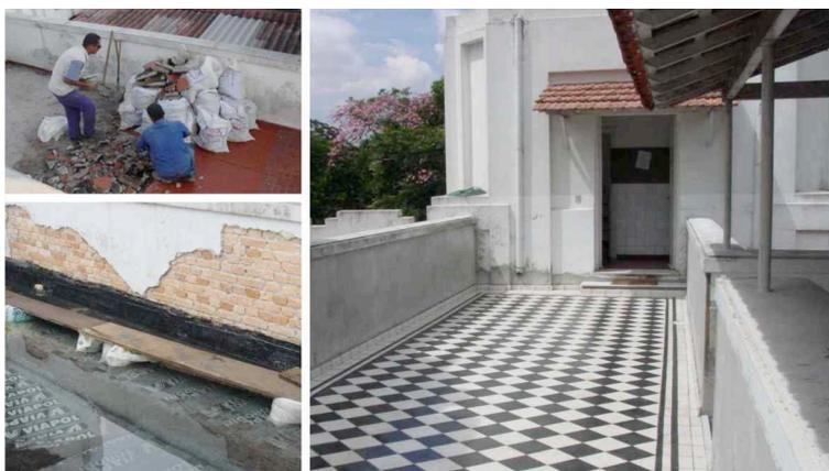
Figura 04 – Troca completa do sistema de impermeabilização da laje do edifício principal do Parque CIENTEC (edifício 05, Administração). Fonte: elaborada pelos autores.
