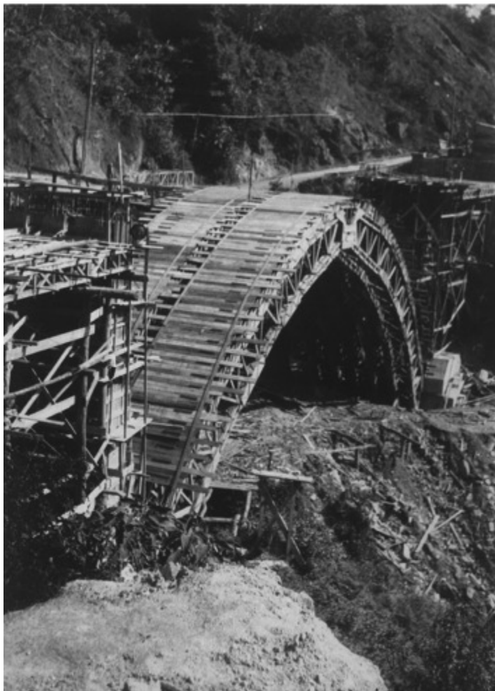
Figura 4: Ponte sobre o Rio Tietê. Montagem da estrutura de ferro (1902-1903). Autor desconhecido.
