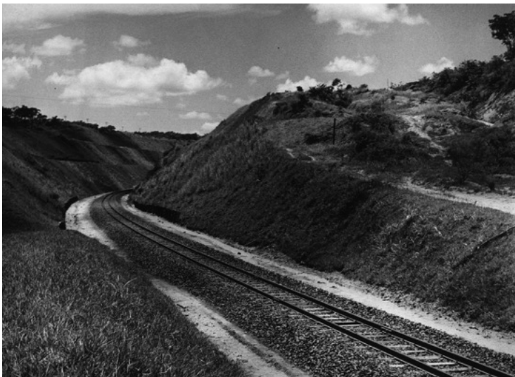
Figura 11: Aterro da Variante Tambaú-Bento Quirino, corte 35, Km 230. Companhia Mogiana. Autor desconhecido.
