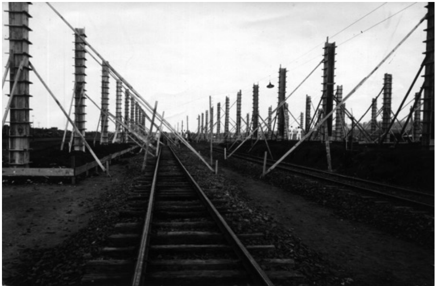
Figura 5: Construção da Estação nova de Ribeirão Preto (1964). Projeto de Oswaldo Bratke. Autor desconhecido.
