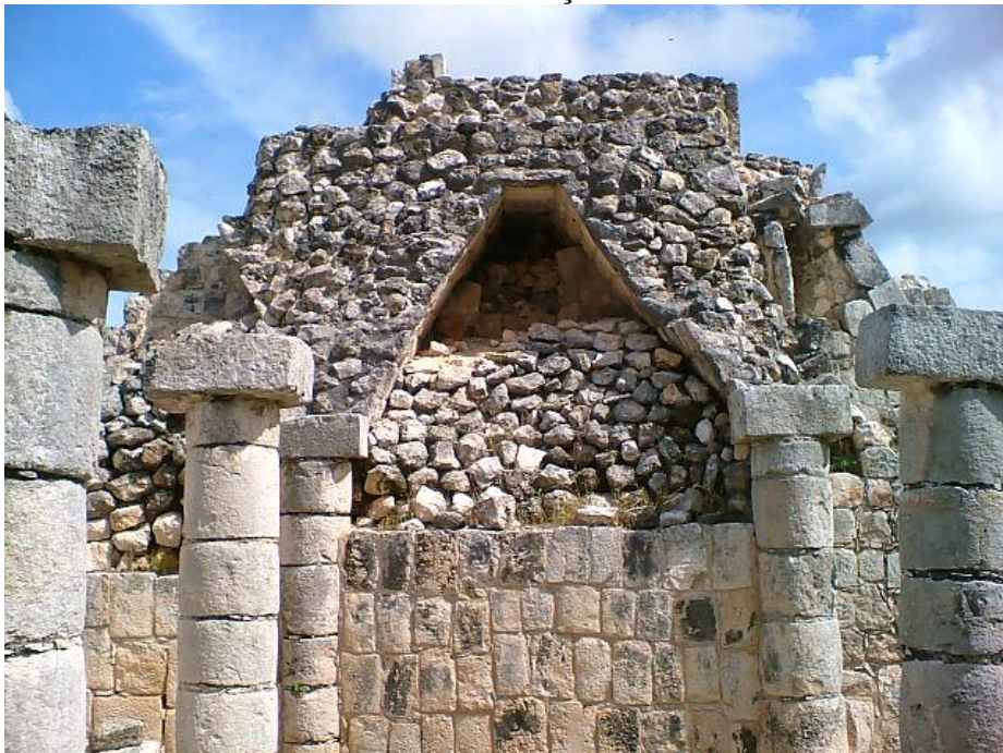
FIGURA 3. Sistema de construção maia com uso de bóvedas
