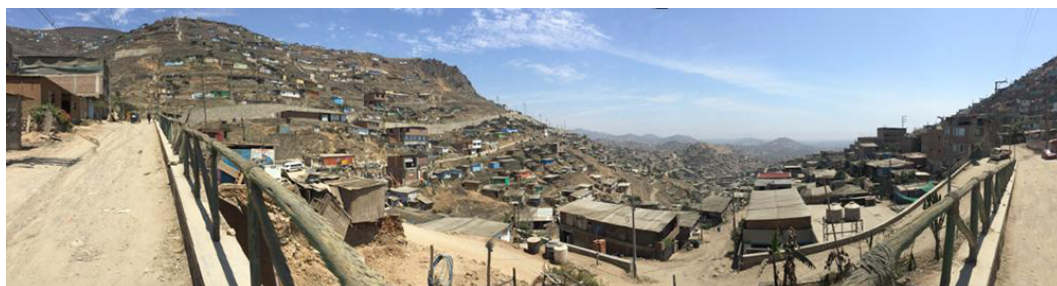
Figura 2. Panorámica de La Nueva Rinconada, desde el Asentamiento Humano Ciudad Nuevo Milenio.
