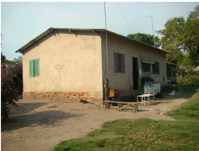
Figura 24: Residência de alvenaria de uso familiar, com a indicação de esteio periférico da antiga casa do tipo palafita
