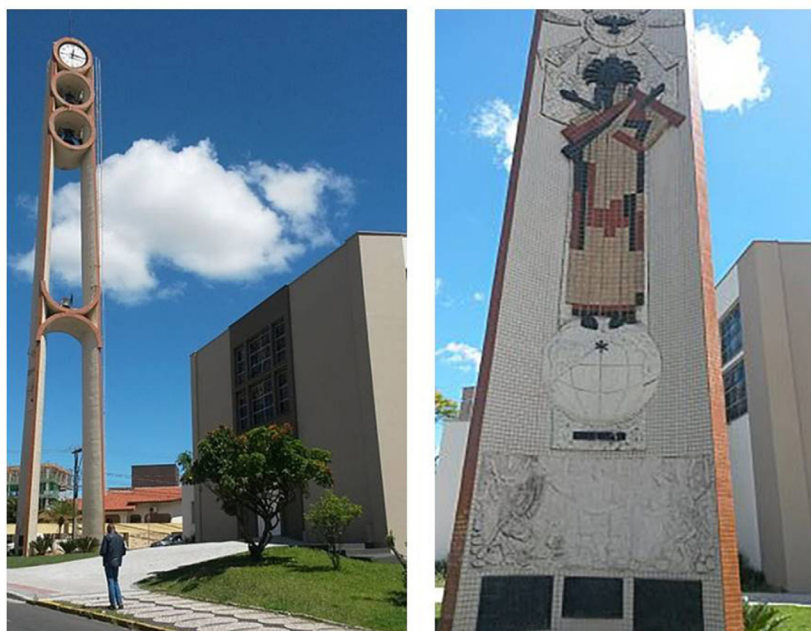
Figura 2 – Torre da Gratidão (vista frontal e lateral)
