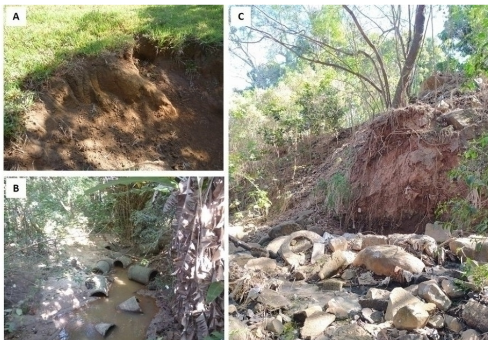
Figura 5 - [A] Erosão de margem ocasionada pelo escoamento superficial drenado para o interior da área de preservação permanente do Córrego Buritizinho, Uberlândia - MG. [B] Leito assoreado do Córrego Perpétua, Uberlândia-MG. [C] Erosão de margem no Córrego Buritizinho, na imagem é possível identificar que o processo erosivo já começa a comprometer a estabilidade da vegetação existente no local.
