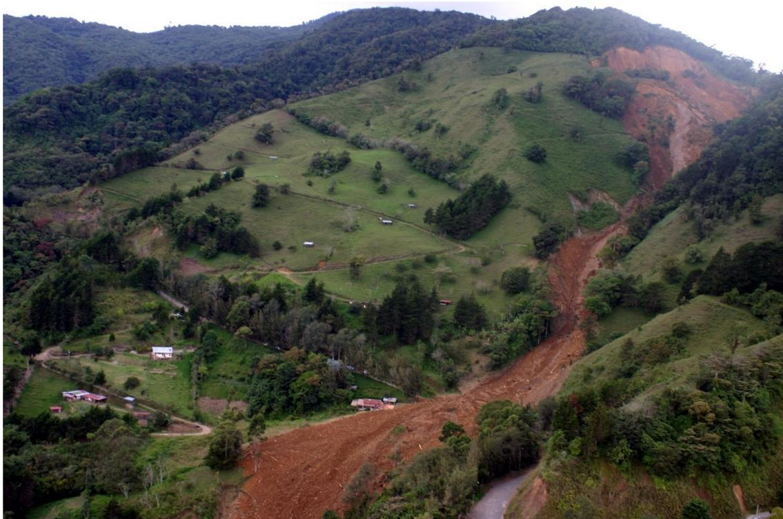
Figura 3 - La imagen muestra la corona de desprendimiento de los eventos ocurridos en 2003 y 2005. El primer evento movilizó 500000 m<sup>3</sup>, en tanto el segundo deslizamiento convertido en flujo de detritos consistió de 1 millón de m<sup>3</sup> que se depositó en un área de 15000 m<sup>2</sup>, proveniente de un área susceptible a deslizarse en el futuro estimada en 47000 m<sup>2</sup>. Fuente: CNE, 2005.
