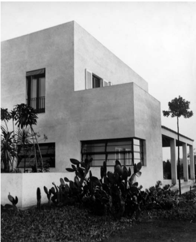
Vista lateral da Casa Mina e Gregori Warchavchik. Notar janela de canto e alpendre à direita. (Acervo Biblioteca da Faculdade de Arquitetura e Urbanismo da USP)
