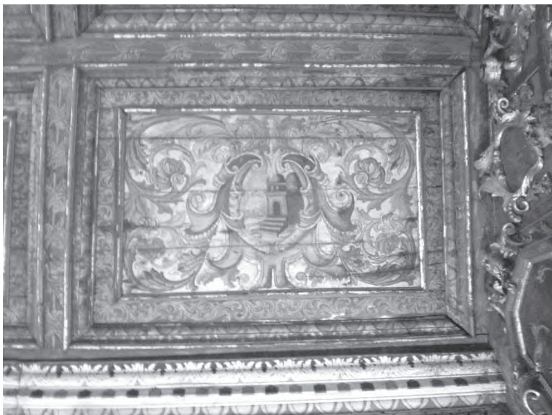
Ex.4 – Detalhe do forro da nave da Capela de Nossa Senhora do Ó
