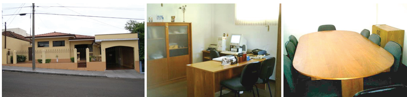
Figura 8. Sede própria da ABPol situada na Rua São Paulo, 994 e detalhes de seu interior.
