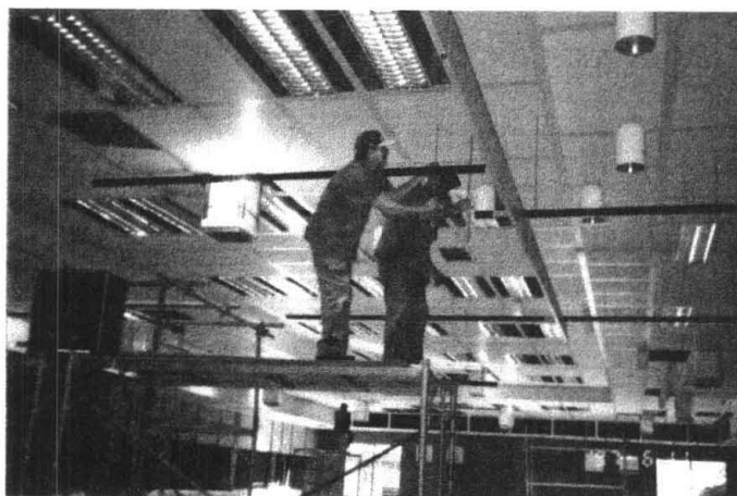
Fig. 10: Montagem do teto – Colocação dos baffles
