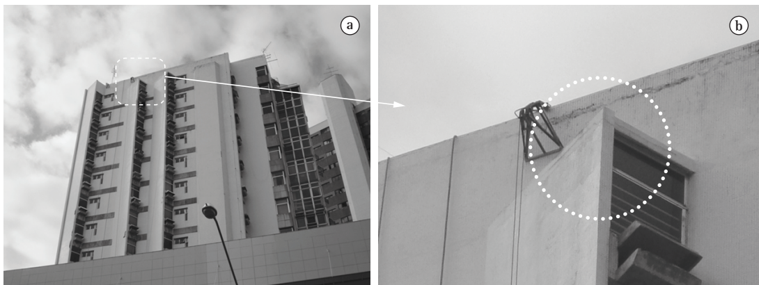
Figura 10. a) Fachada lateral direita – obra A. b) Detalhe da arquitetura da edificação que dificulta o acesso – obra A. Fonte: pesquisa de campo.
