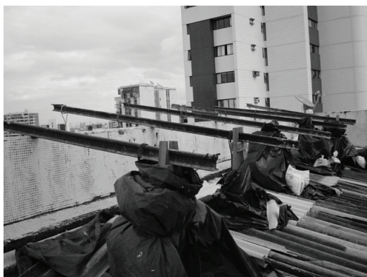
Figura 7. Estrutura de sustentação dos andaimes – obra B. Fonte: pesquisa de campo.
