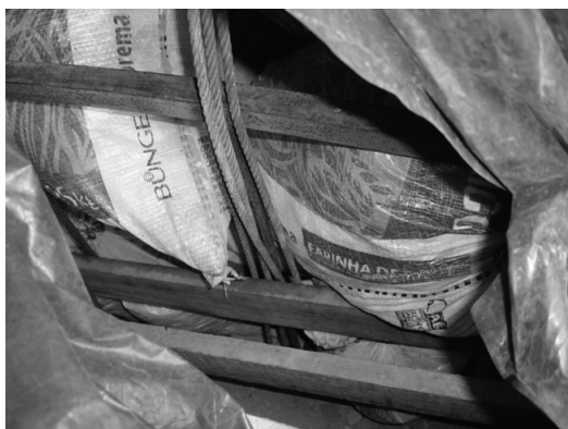
Figura 8. Ancoragem dos cabos de fixação dos cintos em sistema contrapeso – obra B. Fonte: pesquisa de campo.
