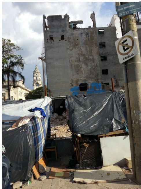
Figura 3 Maloca localizada na rua Helvetia quase esquina com alameda Cleveland Fonte: Coleção particular do autor.
