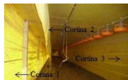
Figura 2. Disposición de cortinas dentro del galpón para aislamiento térmico
