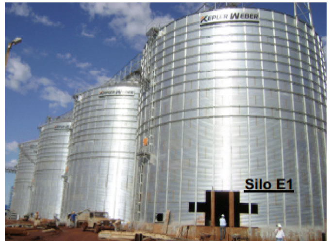
Figura 2. Vista dos 4 silos que integram a bateria E, com destaque para o silo E1 analisado
