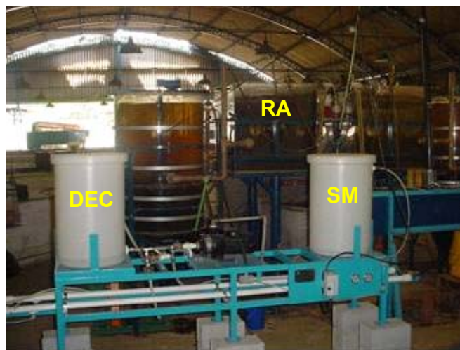
Figura 2. Sistema de lodos ativados composto por reator aerado (RA) e decantador (DEC) junto a sistema de membranas (SM)
