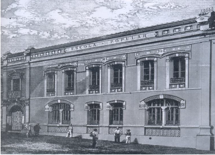
Figure 2 – The building of Sociedade Onze de Agosto.
