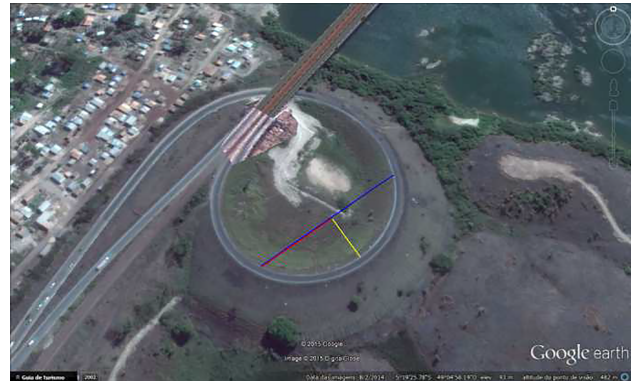
Figura 8 - Trecho em curva na saída de uma ponte na BR 155. Na presente figura D = 68,5 m (linha em vermelho na versão eletrônica) e d = 38,5 m (linha em amarelo na versão eletrônica). Créditos:Google Earth.
