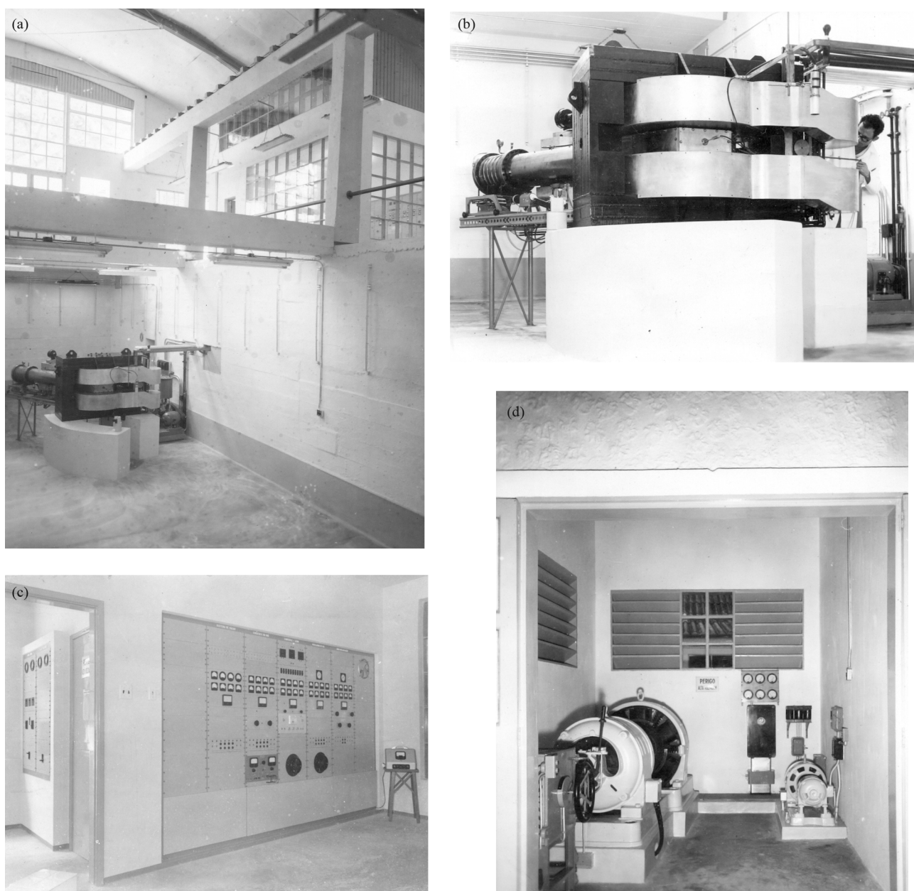
Figura 13 - O equipamento e as instalações durante a inauguração. (a) Panorâmica da localização do equipamento. (b) O engenheiro Engelberto Werckmeister introduz amostra na câmara de análise. (c) Painel de controle. (d) Sala do gerador de radiofrequência.
