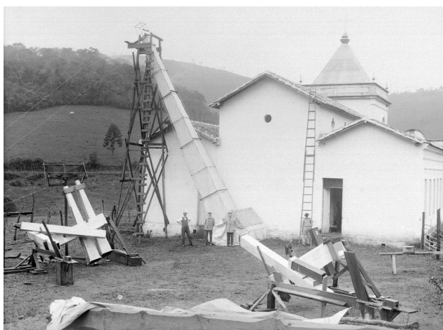
Figura 9: El instrumental instalado, se destaca la gran cámara de 12 m de distancia focal, y a la izquierda, el conjunto de cámaras gemelas destinadas a la verificación de la predicción de Einstein. Fuente: APOAC.
