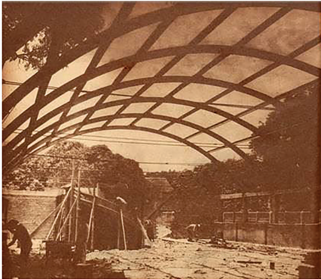
Figura 4: Pavilhão Mário de Almeida sendo construído no início de 1950 na Praia Vermelha [73, p. 46].
