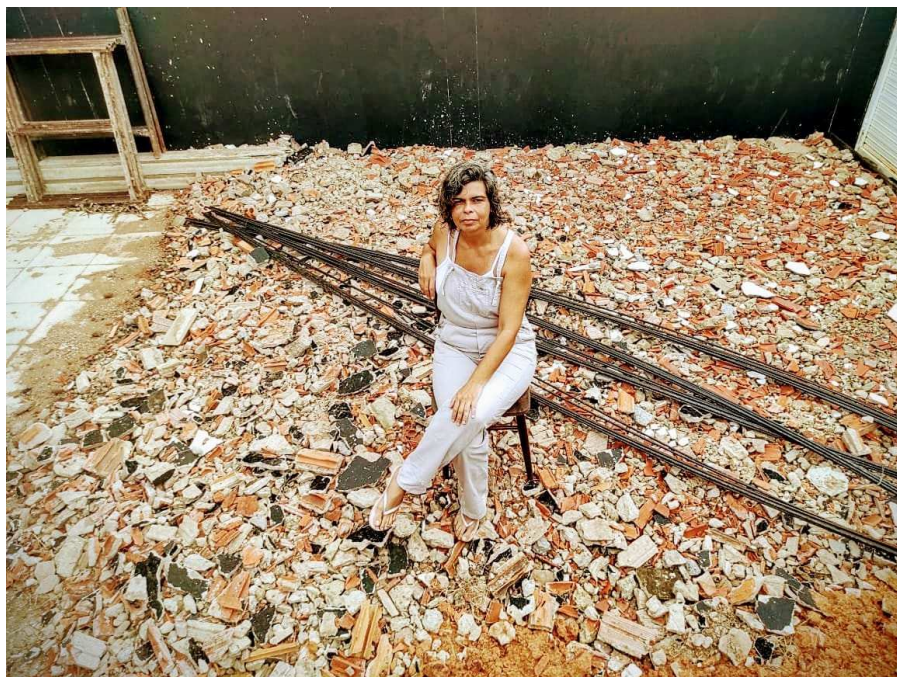
Figura 3: Demolição para edificação do Teatro Xama. abril de 2021. Foto: Nicolle Machado.
