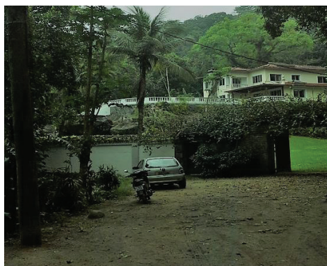
Figura 16 - Mansão construída acima da cota 100 e a infraestrutura de energia da Light.
