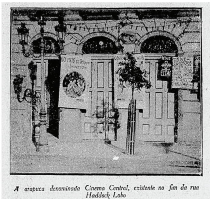
Fachada do cinema Central
