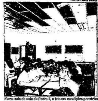
Uma sala de aula do Pedro II, o teto em condições precárias
