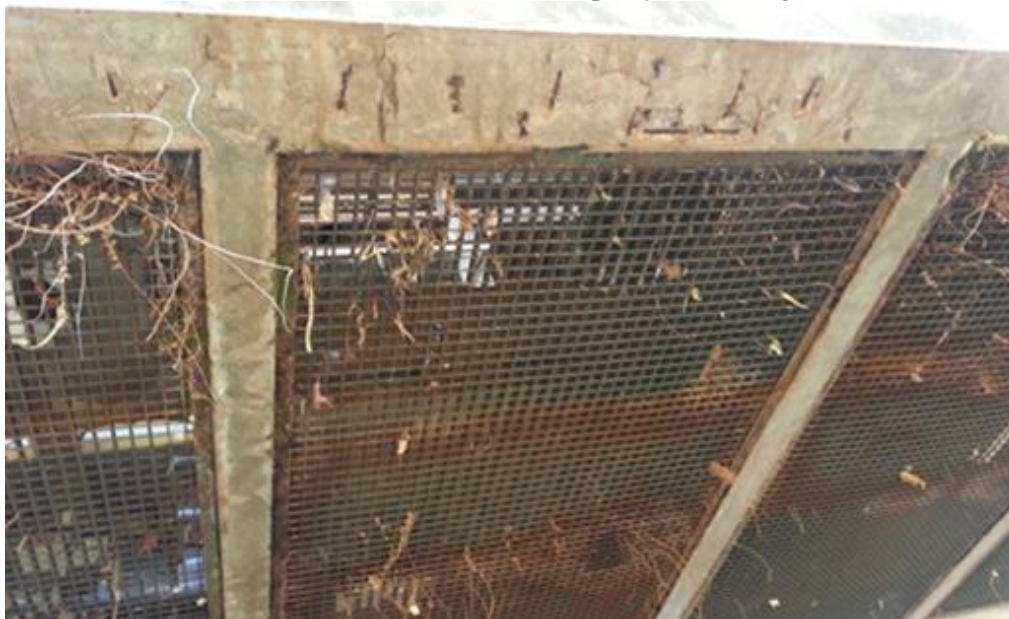
Figura 7. BCMON – Início da exposição de ferragens
