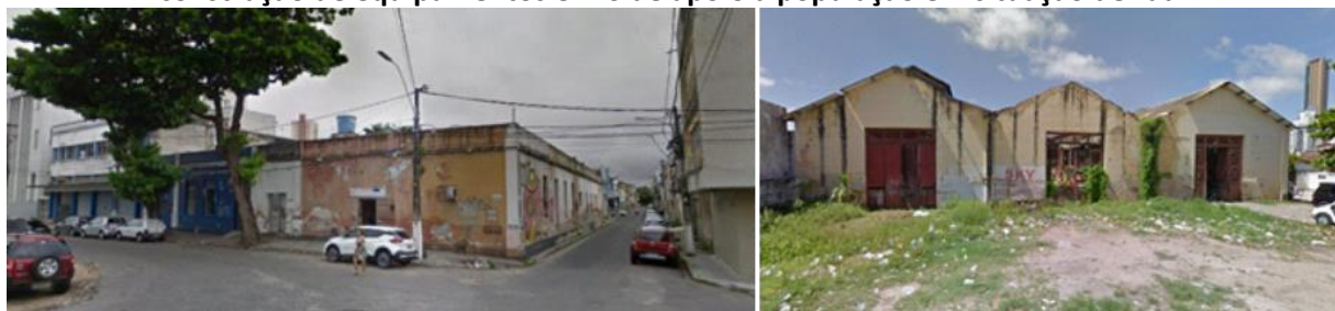
Figura 4 - Edifício do SPU (esquerda) e Galpões da RFFSA (direita) solicitados pelo MNPR para construção de equipamentos e HIS de apoio à população em situação de rua
