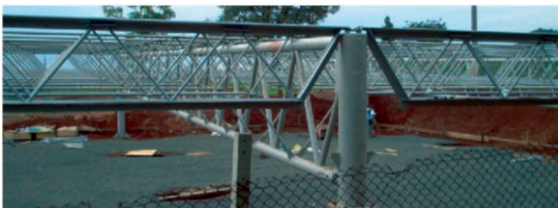
Figura 2 Estrutura completamente montada.
