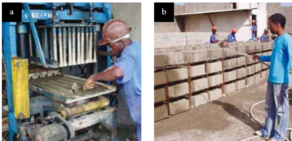
Figura 3 Produção dos blocos em uma empresa de pré-moldados: a) Aspecto da prensa utilizada; b) Cura dos blocos por aspersão.
