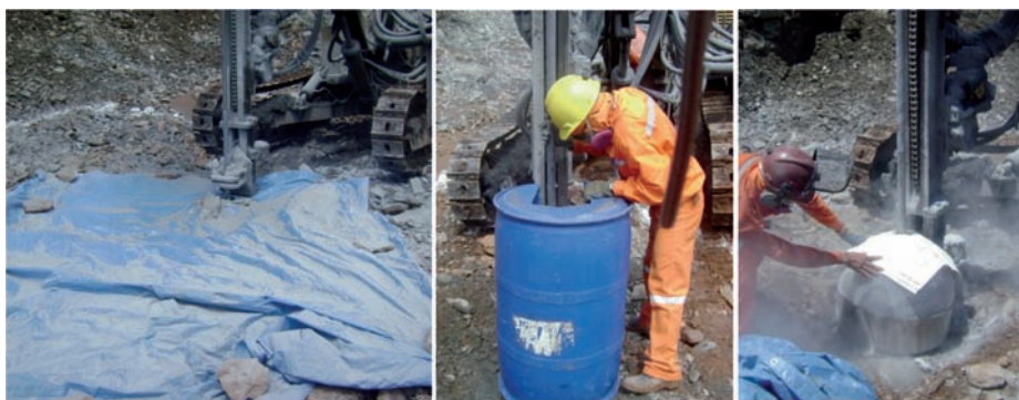
Figura 3 Diferentes procedimentos de amostragem: lona, tambor e amostrador setorial.
