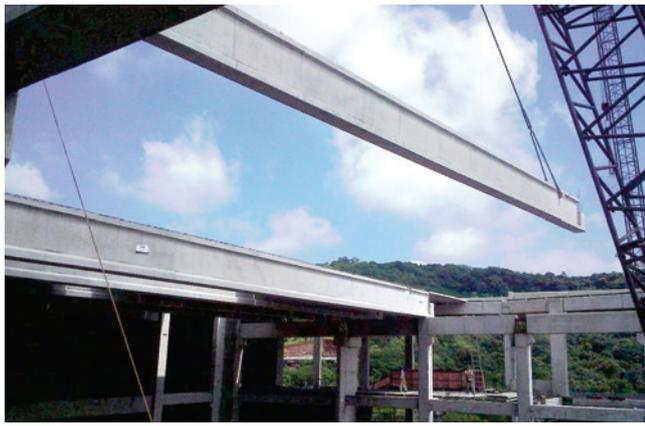
**Figura 26 – Viga biapoiada**
