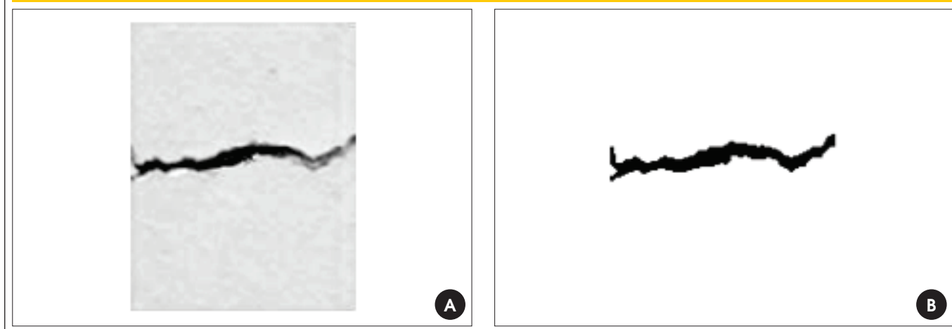
Figura 6 – (a). Imagem de fissura em alvenaria representada em escala de cinza com 256 níveis de cinza. 6(b). Imagem após processo de binarização
