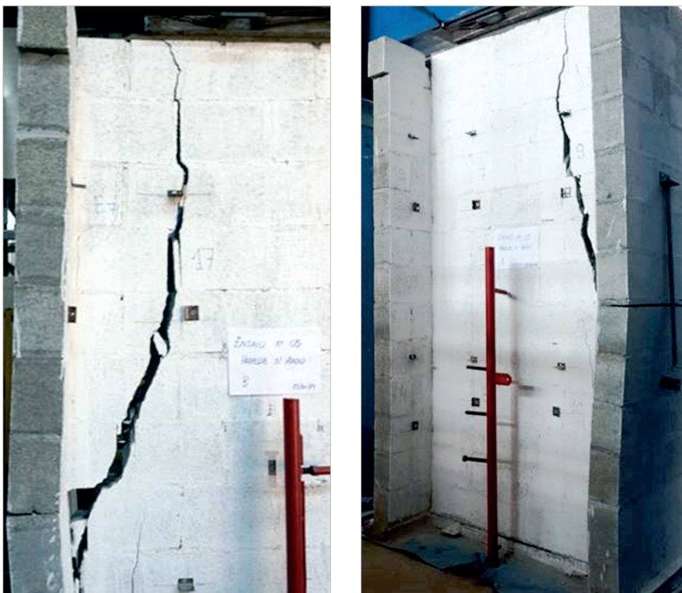
Figura 16 - Ruptura - Parede com flanges sem apoio central 05
