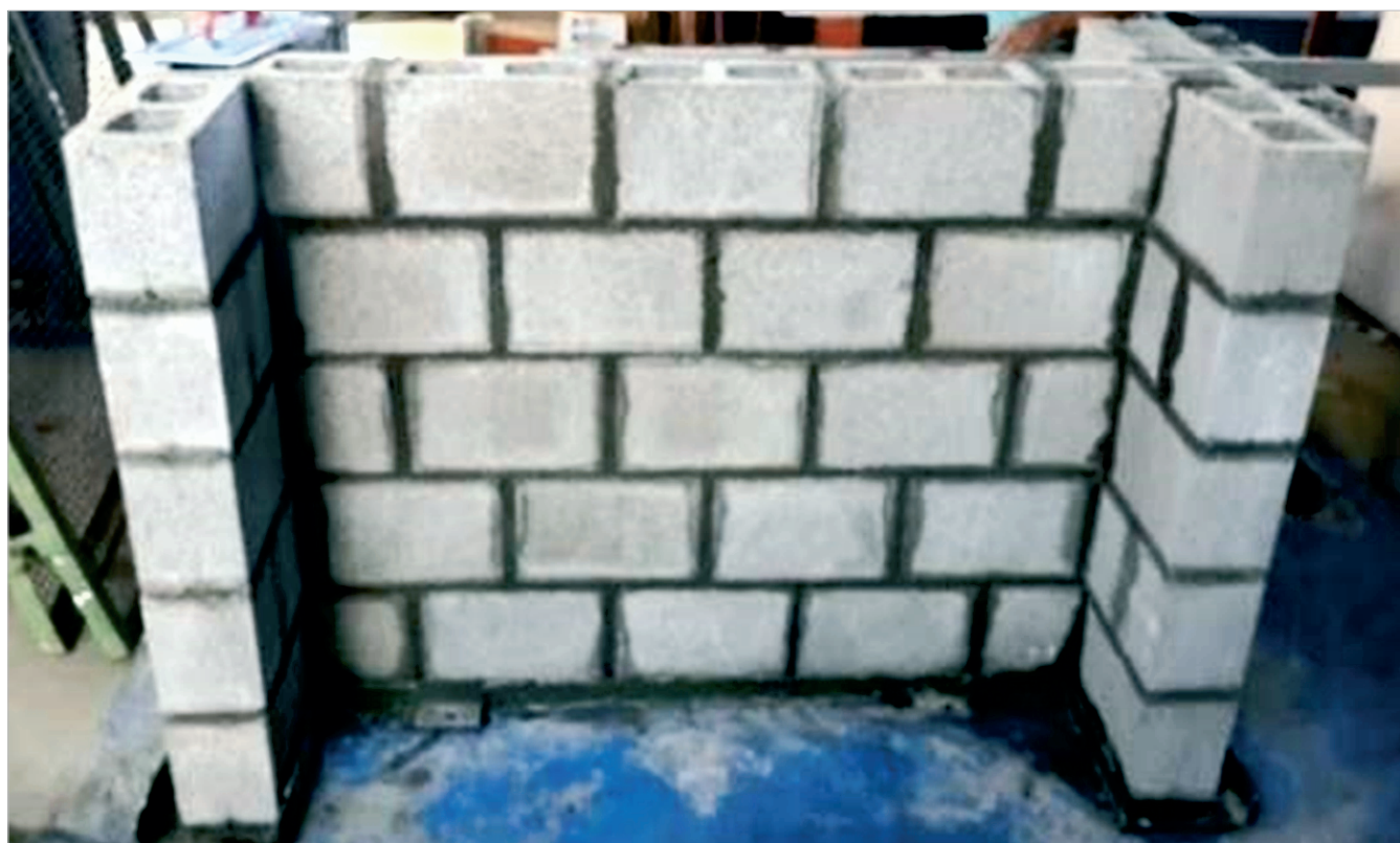
Figura 2 – Primeira etapa da parede com flanges de alvenaria executada
