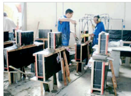
Concretagem dos blocos
