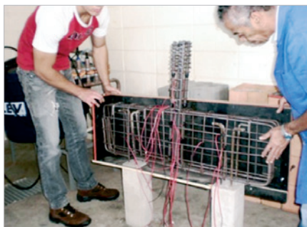
Montagem das armaduras dos blocos nas fôrmas
