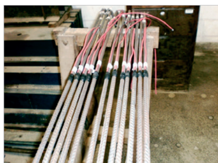
Instrumentação de armaduras
