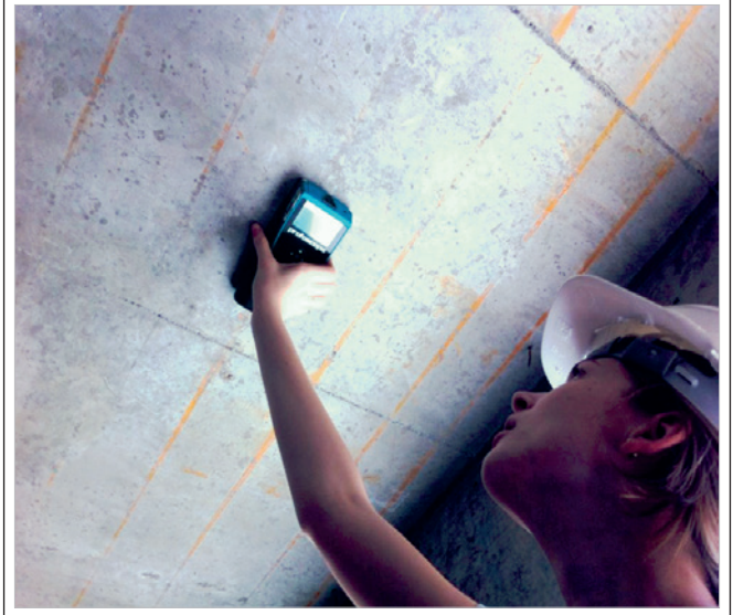
Figura 10 – Medição do cobrimento da armadura positiva das lajes
