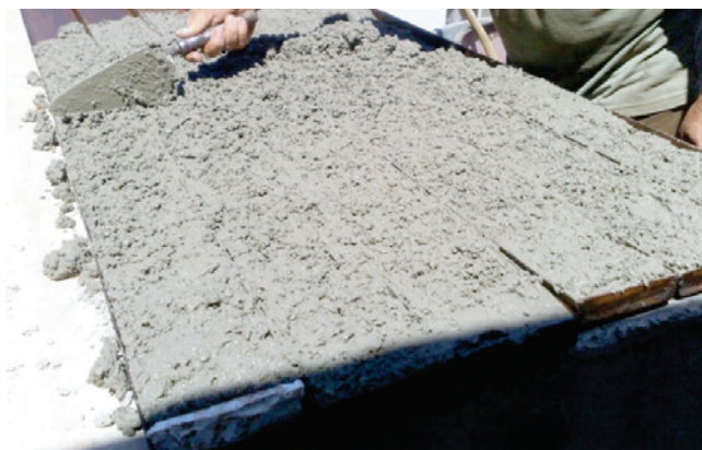
Figura 7 – Preenchimento das fôrmas
