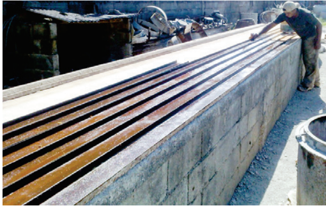
Figura 6 – Umedecimento das fôrmas com óleo
