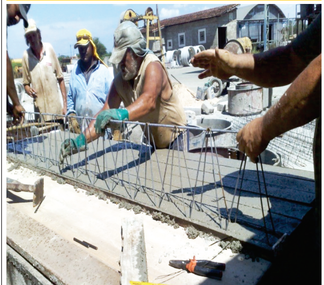
Figura 9 – Inserção da armadura
