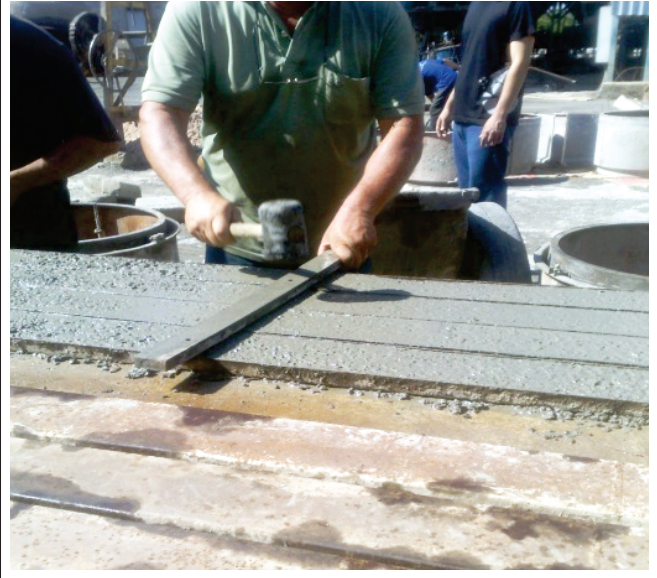
Figura 8 – Vibração do concreto
