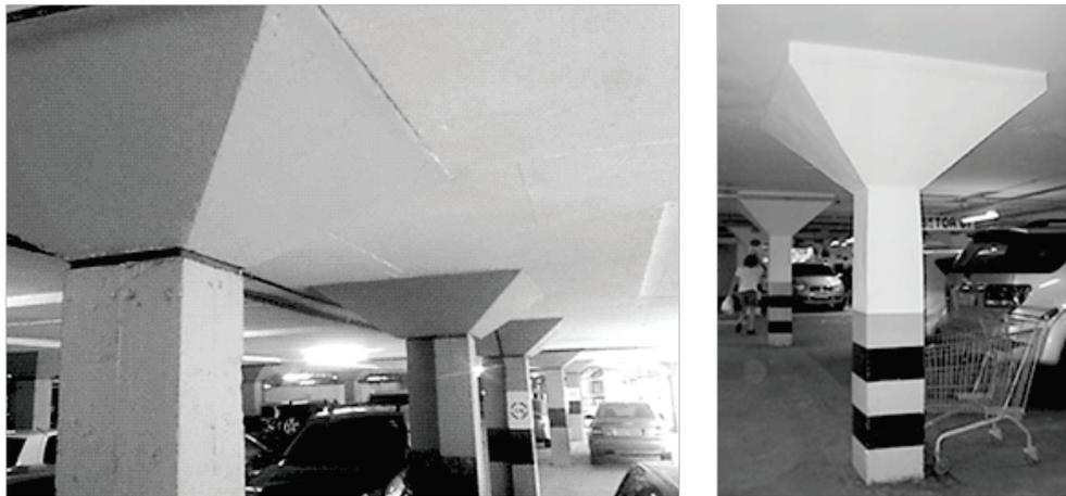
época um dos maiores desafios era a determinação dos esforços em um pavimento sem vigas, apenas com apoios pontuais, sendo comum grande variação na taxa de armadura de flexão dentre os diferentes sistemas. Segundo Melo [4], em 1911 ocorreu o primeiro acidente estrutural em um edifício com lajes lisas. Foi o desabamento do edifício *Prest-o-Lite* nos EUA, onde a ruptura por punção que levou o edifício todo à ruína evidenciou a necessidade de estudar melhor o comportamento da ligação laje-pilar.
