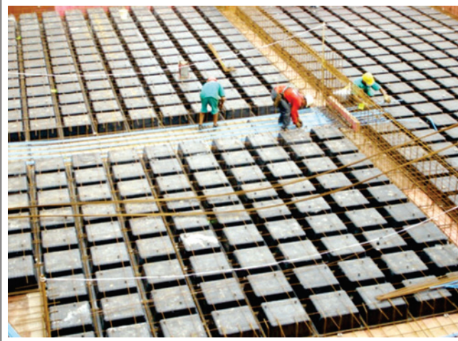
Figura 2 – Laje nervurada em duas direções, LNB
