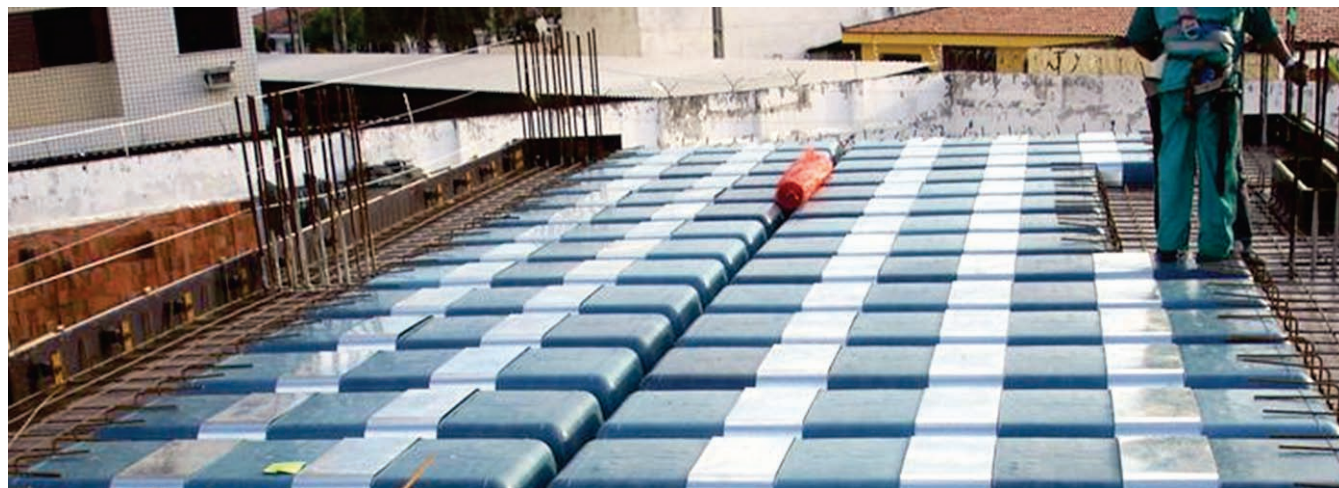
Figura 3 – Laje nervurada em uma direção, LNU
