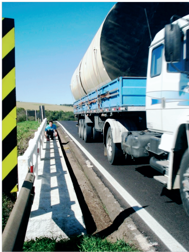
Figura 6 - Fonte de vibração da estrutura para uma amostra no viaduto V1
