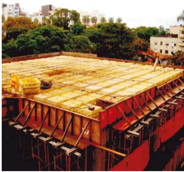
Figura 13 – Fôrma pronta para concretagem
