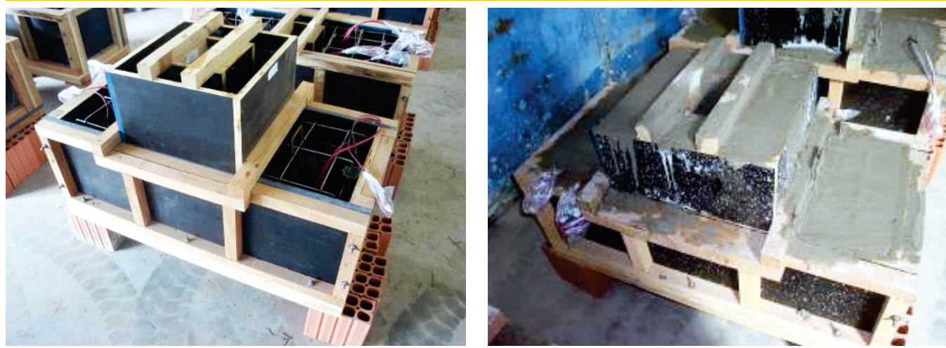
Figura 6 - Concretagem dos blocos de fundação
