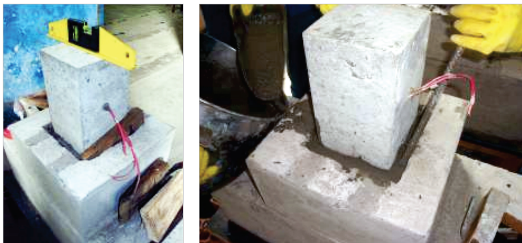
Figura 7 – Posicionamento do pilar no cálice de fundação e preenchimento com graute
