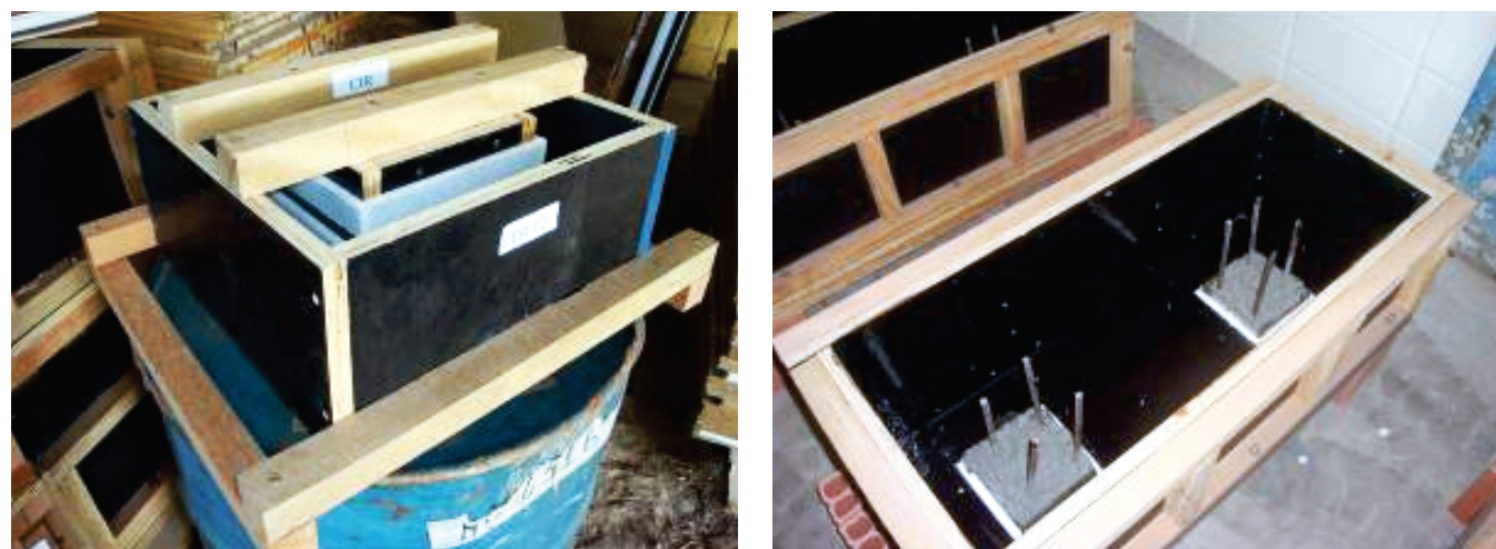
Figura 3 – Fôrma do cálice e dos blocos
