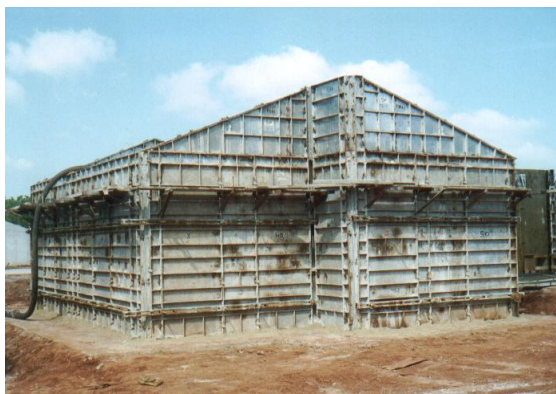
Figura 1: Fôrma das vedações montadas.
