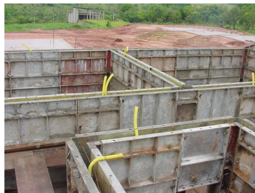
Figura 2: Fôrma montada: detalhe das instalações elétricas já embutidas.
