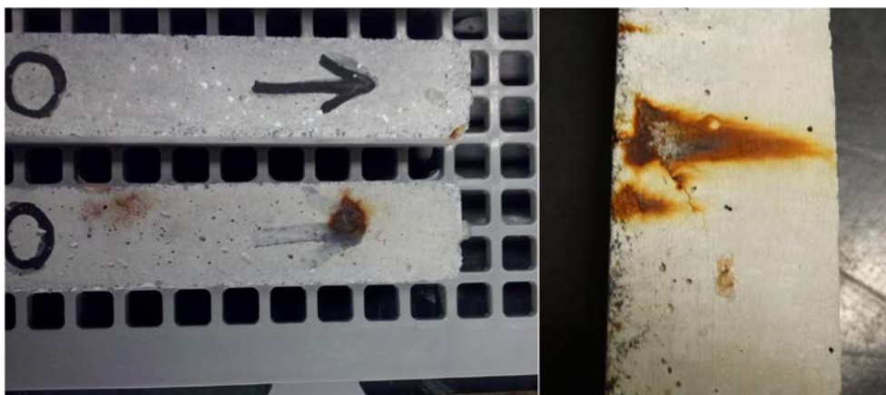
Figura 7: Barras de argamassa com adição de 10% de pirita em substituição à areia com início de fissuração e manchas oriundas do processo de oxidação do sulfeto
