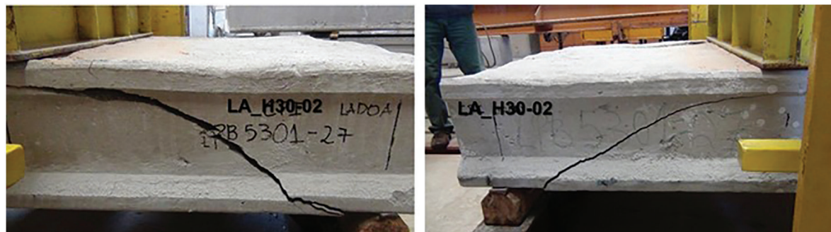
Figura 14: Ruptura por cisalhamento da nervura LA_H30-02 [14].
