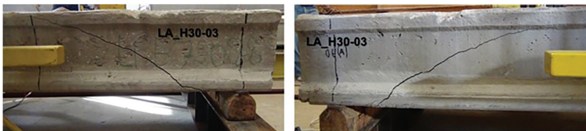
Figura 15: Ruptura por cisalhamento da nervura LA H30-03 [14].
