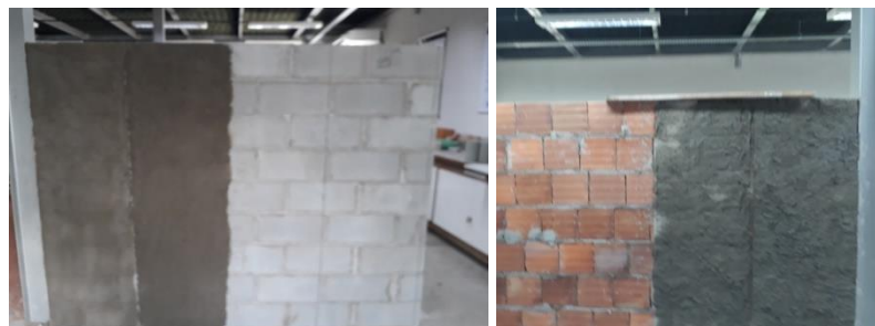
Figura 7: Paredes de vedação sendo chapiscadas: bloco concreto (esquerda) e cerâmico (direita).
