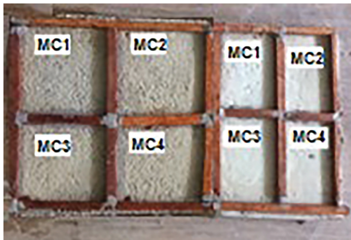
Figura 6: Local de aplicação dos microconcretos.
