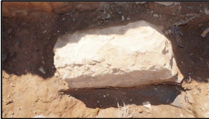
Figura 4: Uma das pilastras de sustentação do teto do barracão. Observar que há uma linha de quebra do lado esquerdo que só poderia ser feita por máquina devido à grossura da estrutura (seta em vermelho). Fonte: Acervo do autor (2015).
