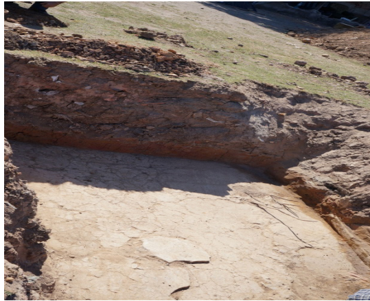
Figura 2: Vigas de sustentação das pilastras do barracão contorcidas no sentido norte-sul (indicado pela seta vermelha), demonstrando como houve uma ação mecânica de destruição da Gomeia.
