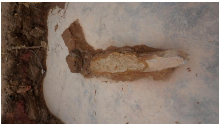
Figura 5: Pilastra encontrada no contexto do Roncó. Observa-se que a sua quebra em ponta só poderia ter sido realidade por meio de maquinário, já que um marrete ou martelo não quebraria o cimento de forma a gerar essa ponta. Fonte: Acervo do autor (2016).
