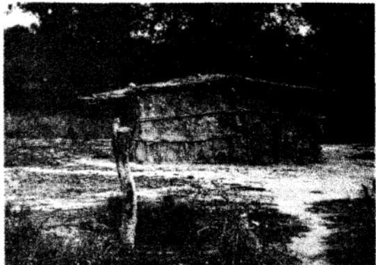
Figura 3. Rancho típico de alto primitivismo, paredes de barro, techo de ramas, y pasto, vivienda de obreros leñateros. La rudimentaria limpieza en torno al mismo logró reducir al mínimo la reinfestación por T. infestans tras una precaria desinsectación. (Observación Villa Carlos Paz, 1966, en area montaraz)
