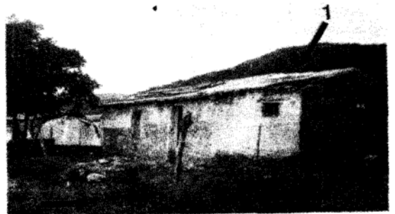
Figura 1. La paradoja triatomínica! En el interior de esta construcción, vivienda de obreros de una empresa agropecuaria, no se encontraron vinchucas; sin embargo las había en el entretecho abierto (flecha 1) refugio de murciélagos, ejemplares de Triatoma platensis . Se entraron también ejemplares en una madriguera de zarigüeya y ratones en el matorral vecino a la casa (flecha 2). (Observación Villa Carlos Paz, 1966)
